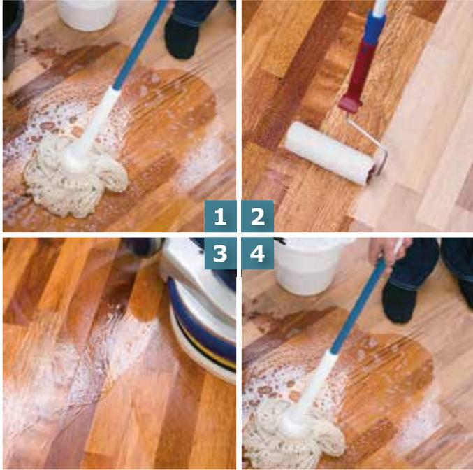
Ein geöltter Boden sollte vor dem ersten Gebrauch mit Pflegeöl endpoliert werden – dieses gilt für Böden, die werkseitig mit natürlich härtenden Ölen geölt sind und alle manuell geölten Böden. Durch diese Ersteinpflege wird die Oberfläche zusätzlich verdichtet und besonders strapazierfähig.
